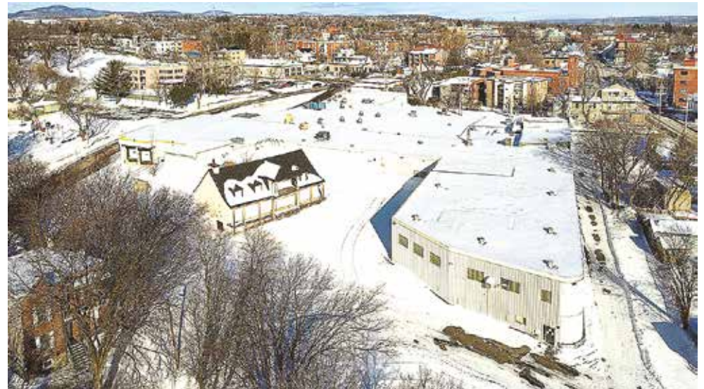
Situé dans l'arrondissement historique de Beauport, au 553, avenue Royale, ce grand terrain commercial couvre une superficie d'un peu plus de 172 000 pieds carrés. L'acquisition de l'ancienne boulangerie Gailuron permettrait aussi à la Ville de Québec de préserver la maison Salaberry-Juchereau-Duchesnay qui se trouve également sur le site. (Photo : gracieuseté Pierre Ménard - Atelier Photo BEAUPORTAIT)
